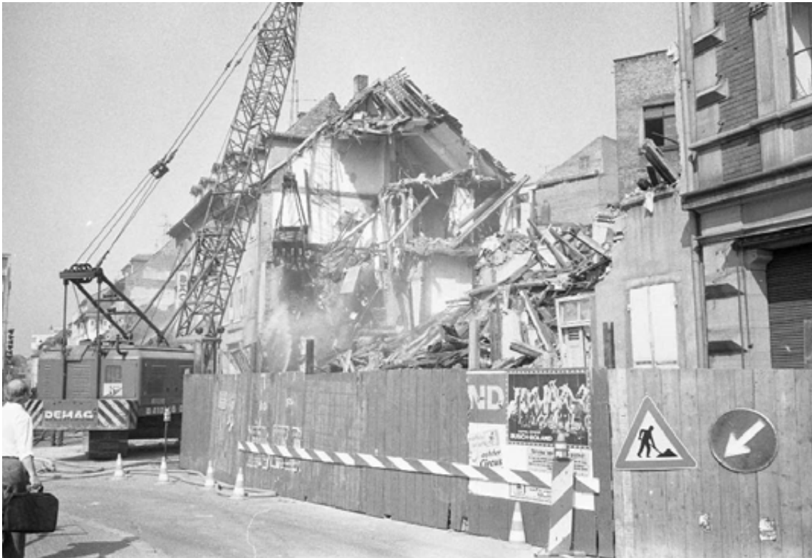
Abbruch Zähringer Straße Quelle: Stadtarchiv Karlsruhe 8/BA A 28 42_4_2 (1974)
