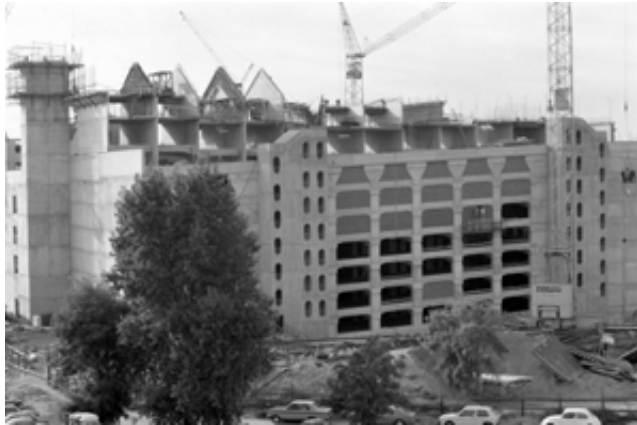
Wohnnutzung auf Parkhaus, Fritz-Erler-Straße Quelle: Stadtarchiv Karlsruhe 8/BA A 34 88_4_02 (1977)
