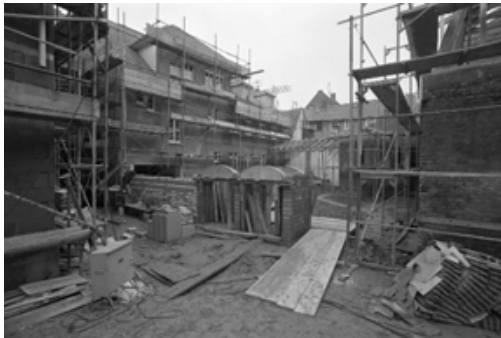
Sanierung Künstlerhaus Brunnenstraße 62, Quelle: Stadtarchiv, Archiv Schlesiger (1979)
